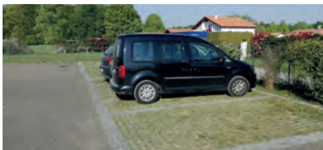
Zona vegetal para la gestión de las aguas pluviales de un aparcamiento - Limoges ©OiEau
