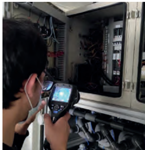
Termografía infrarroja en los armarios eléctricos de una unidad de ultrafiltración ©OiEau
