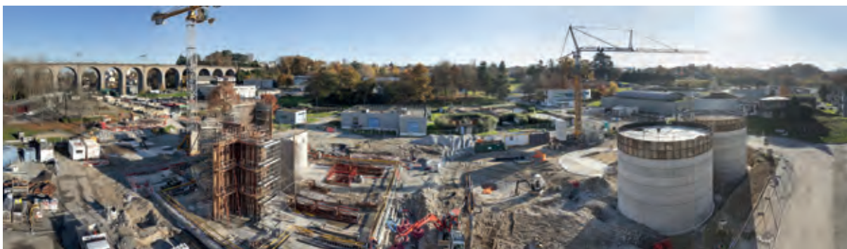
Vista de la obra de renovación de la depuradora de Limoges ©OiEau
