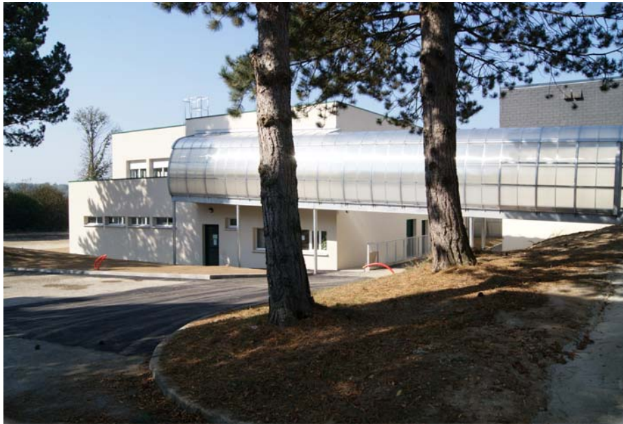
Les nouvelles installations de l'OIEau à la Souterraine dans la Creuse
