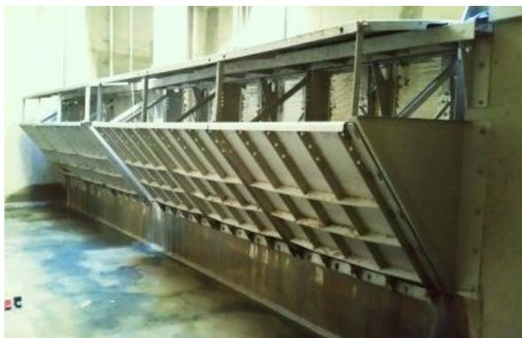
Figure 18 : Dégrilleur vertical. Source/crédit : Hydroconcept
