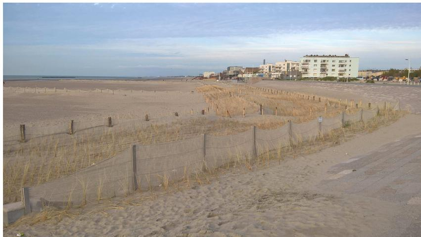
Illustration 10 : rechargement de plage, pose de filets brise vent et plantation d'oyats (techniques souples) pour protéger la digue des Alliés (technique dure) à Dunkerque (Cerema)
