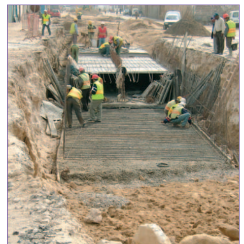
Chantier du réseau d'assainissement d'Essaouira
