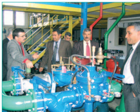
La délégation visite les installations techniques du CNFME
