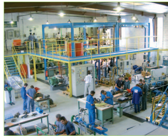
Installations hydrauliques du CNFME à Limoges
