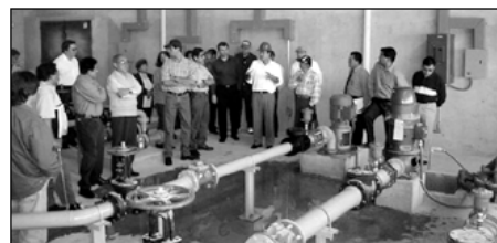
Le pilote pompage et canalisations
