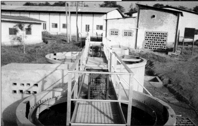
Le pilote de traitement d'eau résiduaires SOAF
