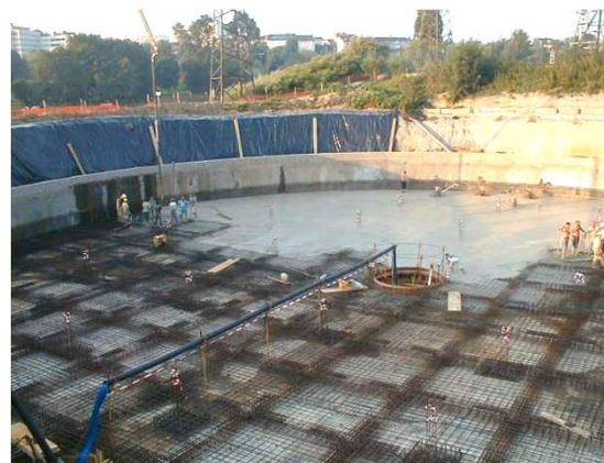
Construction bassin tampon des Casseaux 9 000 m 3 en bord de Vienne en 2002
