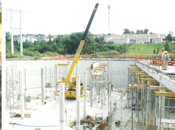
Construction bassin tampon des Casseaux 9 000 m 3 en bord de Vienne en 2002
