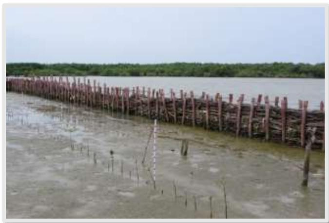
Accumulation de sédiments à l'intérieur des barrages perméables © TONNEJICK F.
