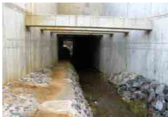
Vue à l'intérieur de l'ouvrage : fil d'eau reconstitué, banquette petite faune, luminosité préservée.
