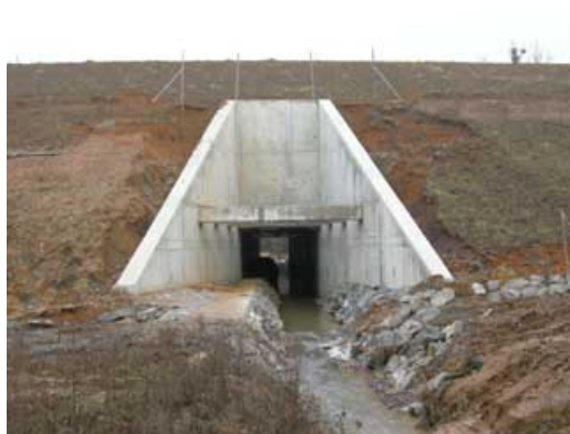
Photographie 16 : Murs en aile et « butons » pour r duire la longueur de couverture : diminution de longueur de couverture de 30 m (65 m au lieu des 95 m initiaux, surco t de 6,3%).
