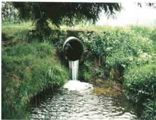
Photographies 1 et 2 : exemples d'ouvrages hydrauliques sous voie communale et voie forestière, incompatibles avec le principe de continuité écologique (source : CETE de l'Est).
