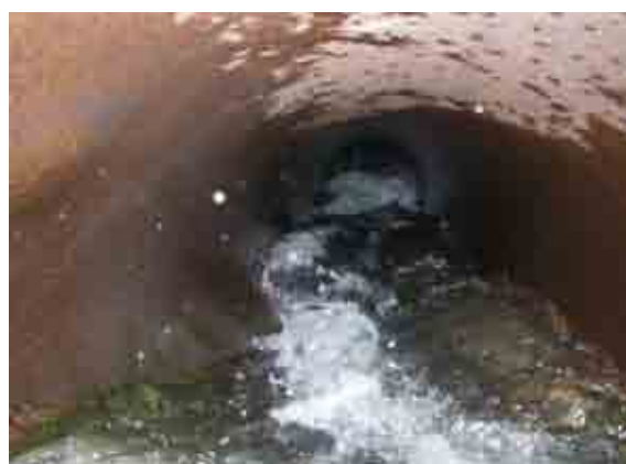
Photographies 3 et 4 : exemples d'ouvrages routiers mal calés ou mal dimensionnés, engendrant une interruption de la circulation des poissons : vitesses de courant supérieures à la capacité de nage des poissons ; étalement de la lame d'eau et absence de rugosité au fond du radier (sources : Onema, Pôle écohydraulique et Service Départemental de la Gironde).
