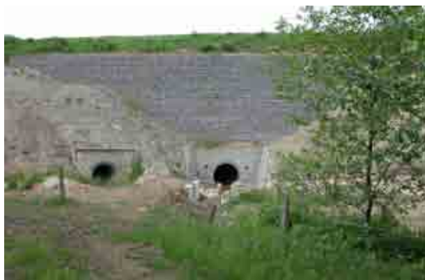
Photographie 17 : Mur en gabions pour soutenir le remblai et r duire la longueur de couverture
