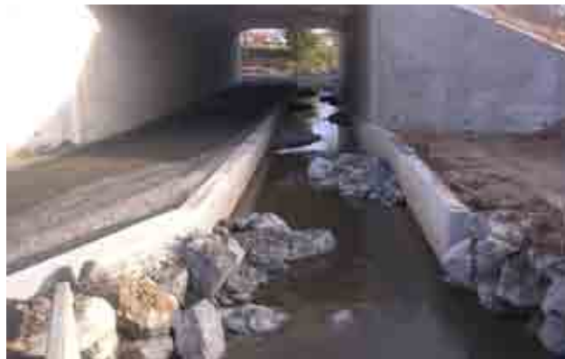
L'ouvrage en cours d'aménagement
