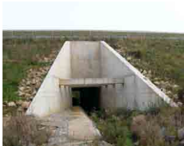
Tête de l'ouvrage.
