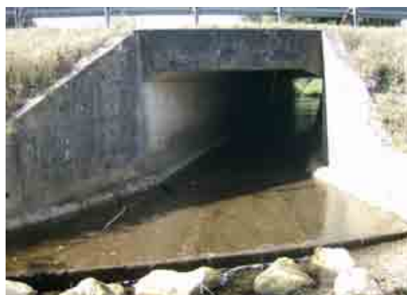
Photographies 3 et 4 : exemples d'ouvrages routiers mal calés ou mal dimensionnés, engendrant une interruption de la circulation des poissons : vitesses de courant supérieures à la capacité de nage des poissons ; étalement de la lame d'eau et absence de rugosité au fond du radier (sources : Onema, Pôle écohydraulique et Service Départemental de la Gironde).
