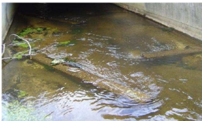
Photographies 11 12, 13 et 14 : Exemples d'aménagements piscicoles dans des ouvrages hydrauliques fermés : seuils (ou déflecteurs ou barrettes) de dissipation de l'énergie hydraulique, de stabilisation du substrat, de concentration des écoulements à faibles débits, créant des conditions compatibles avec les capacités de nage et de saut des poissons (sources : Onema Délégations Interrégionales Sud-Ouest et Rhône-Alpes).
