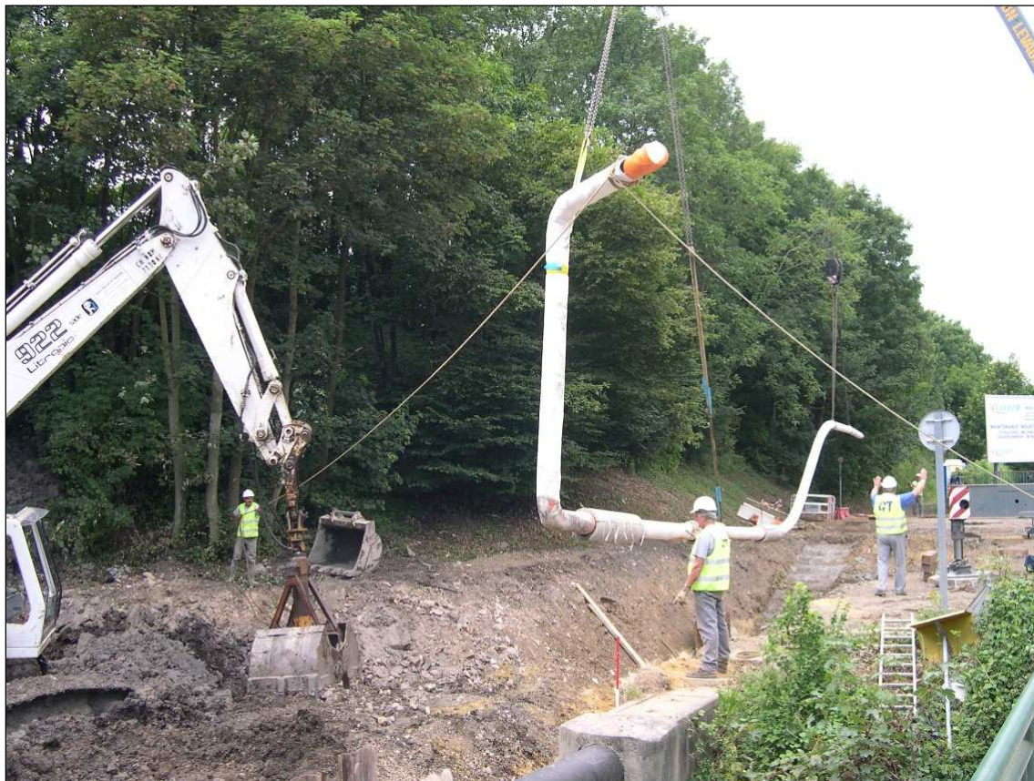
Illustration d'une baïonnette en cours de pose
