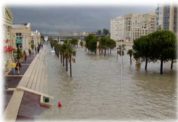
La route de la Mer inondée : de faibles dommages (Source : Egis Eau)
