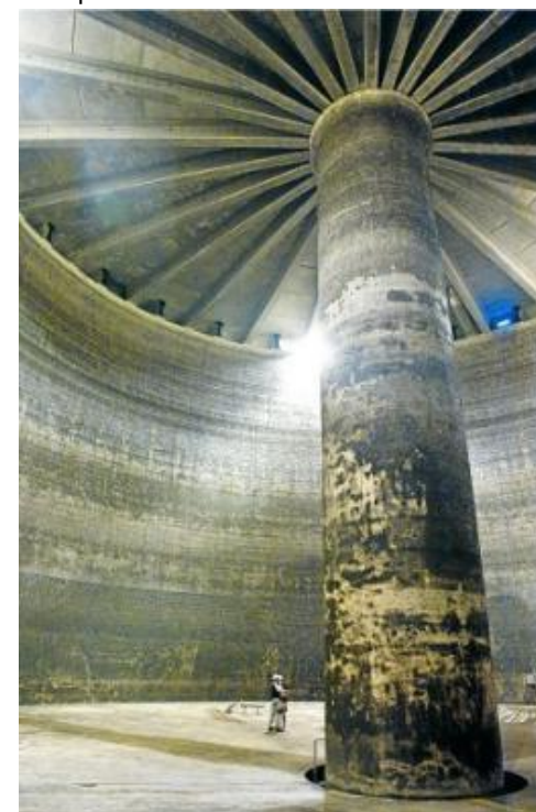
Bassin de stockage des eaux pluviales de la Grenouillère (source :
