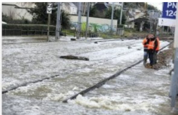
Les inondations de décembre 2010 ont provoqué d'importants dégâts et de longues perturbations ferroviaires
