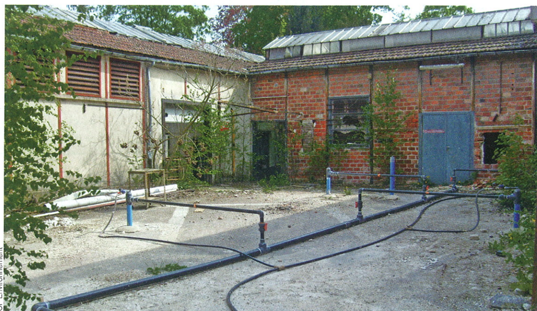
Réseau d'injection pour oxydation chimique.
