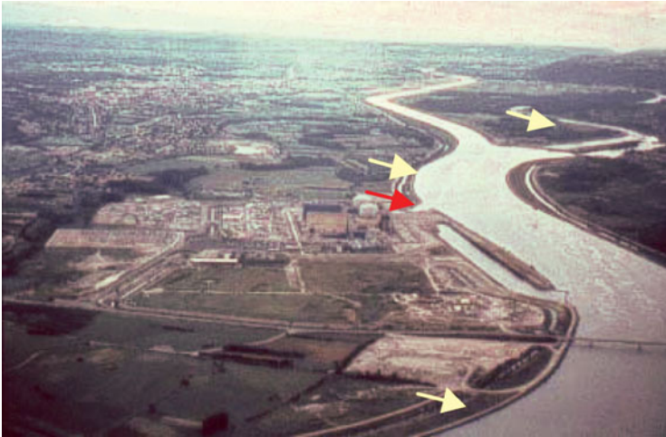
Photo 1. Vue aérienne de l'aménagement de Péage-de-Roussillon et du site de Saint-Alban (Cliché : Frapna 26). Les stations d'étude sont localisées par les flèches jaunes et le rejet du CNPE par la flèche rouge.
