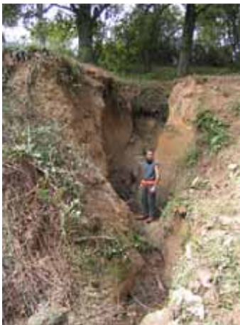
La Goutte des Verrières, Charbonnières (69)
