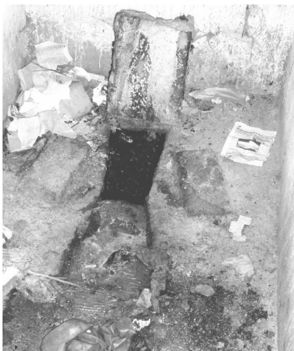
L'entretien des toilettes est parfois très insuffisant. (Source : SIE, Bulgarie)
