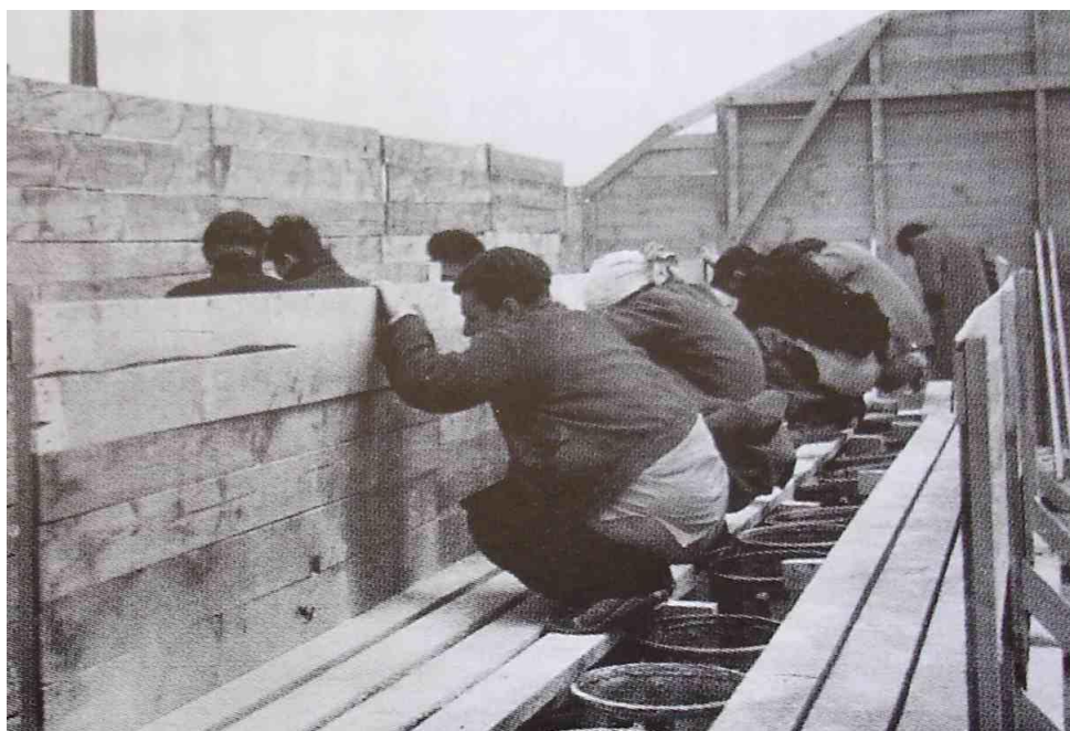
Latrines dans un camp de prisonniers (Europe de l'Ouest, 1940)
