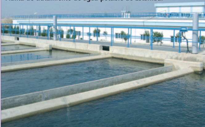
Planta de tratamiento de agua potable de Estambul
