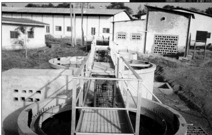
Piloto SOAF de tratamiento de aguas residuales
