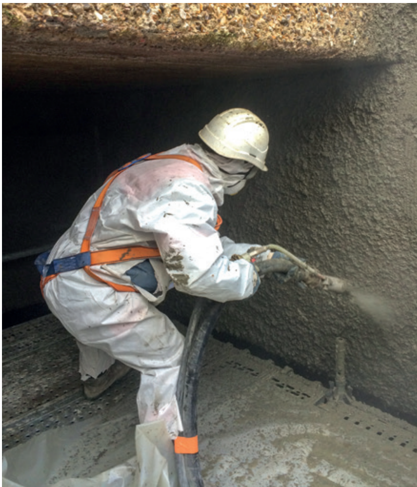
Projection de mortier Ergelit KS2b-L distribué par Hermes Technologie. Ce mortier est destiné à la protection des ouvrages en béton contre les effets de la corrosion bio-sulfurique ( H_2S ). Il peut également s'appliquer à la main ou par centrifugation.
