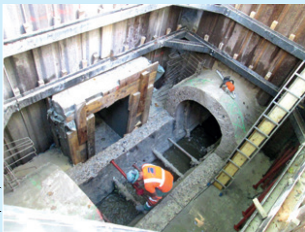
Travaux de réhabilitation de collecteur visitable réalisés à Lyon 4 ème sur le cours d'Herbouville - groupement d'entreprise Nouvetra, Stracchi et Polen'
