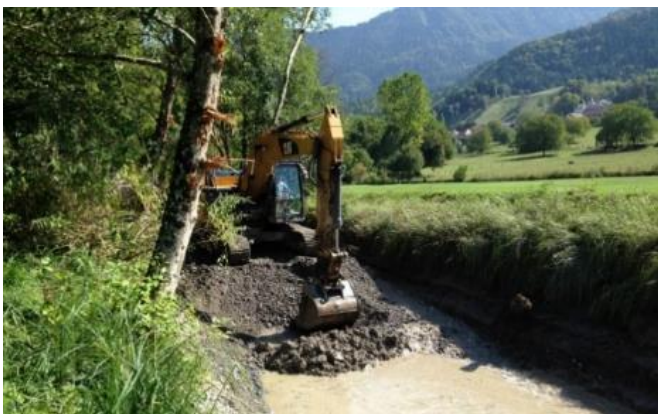
Figure 2 – Curage du cours d'eau l'Eau Morte à l'entrée du Marais, © CCSLA
