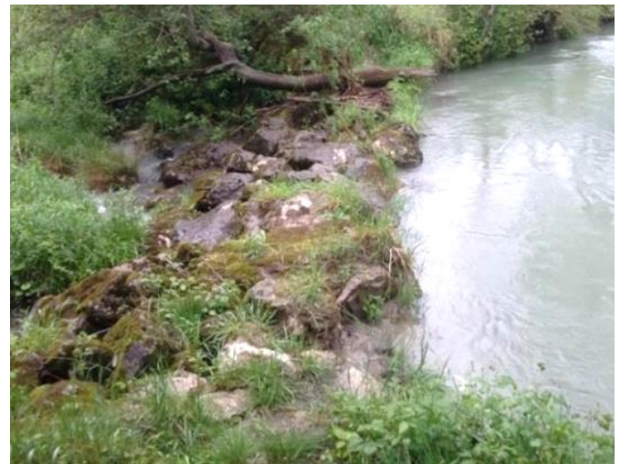
Figure 3 – Seuil du canal de Verthier avant les travaux, © CCSLA
