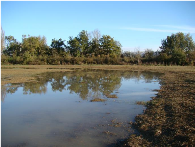
Figure 3 – casier en eau 1 an après les travaux, © ADASEA 32
