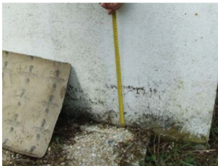
Illustration 24 : Mesure par rapport au sol d'une PHE (Cerema Ouest, Tempête Xynthia, 3 mars 2010 )
