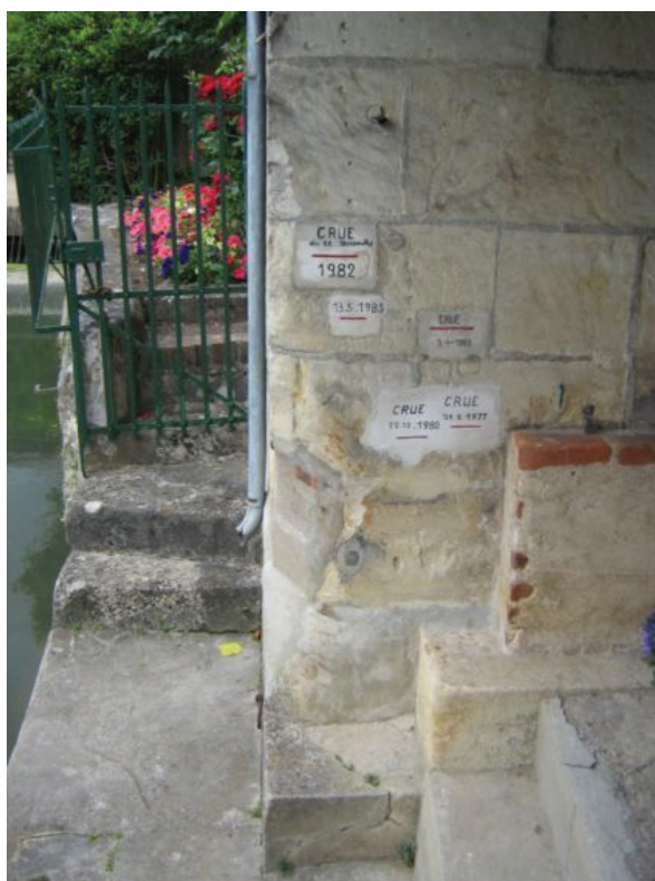
Illustration 14 : Exemple de repères d'inondation : repères de crues de l'Indre à Azay-le-Rideau (Cerema Normandie-Centre/LRB, 2010)
