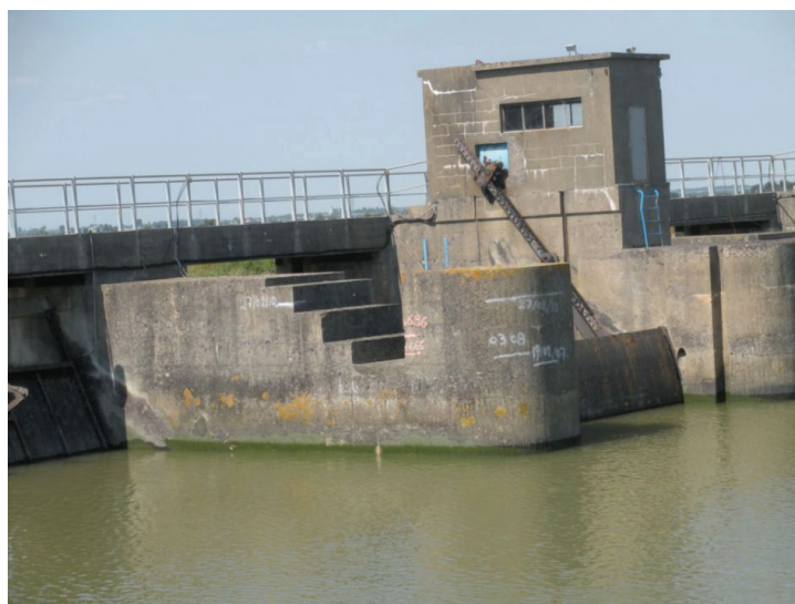
Illustration 19 : Levé de PHE sur ouvrage hydraulique (Cerema Ouest, Xynthia, La Tranche-sur-Mer, 2010)
