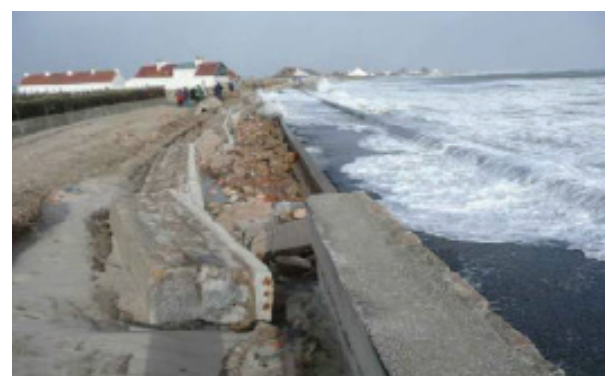
Illustration 8 : Dégradation d'un ouvrage de protection (Geos, Tempête du 10 et 11 mars 2008, Gâvres, 2008)
