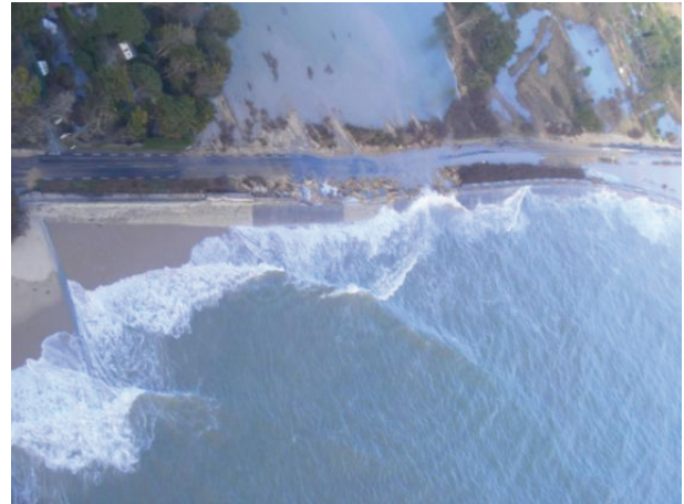
Illustration 10 : Digue détériorée suite à la tempête Xynthia (DDTM 17, Île de Ré, 2010)
