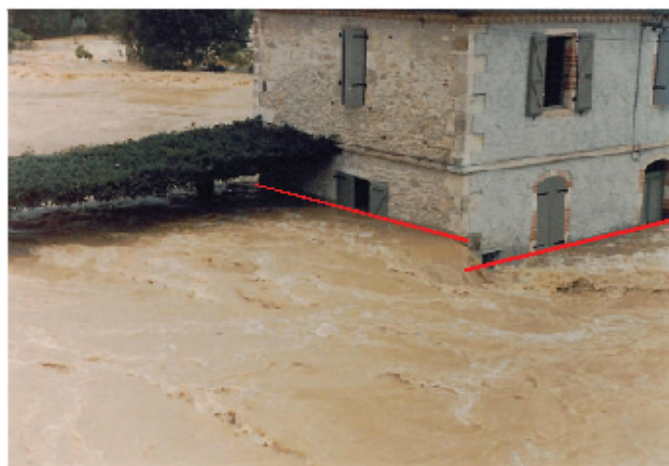
Illustration 22 : Différence de niveaux d'eau d'une cinquantaine de centimètres (moulin de Gimont, crue de la Gimone, 8 juillet 1977, Simone Progin, 1997)
