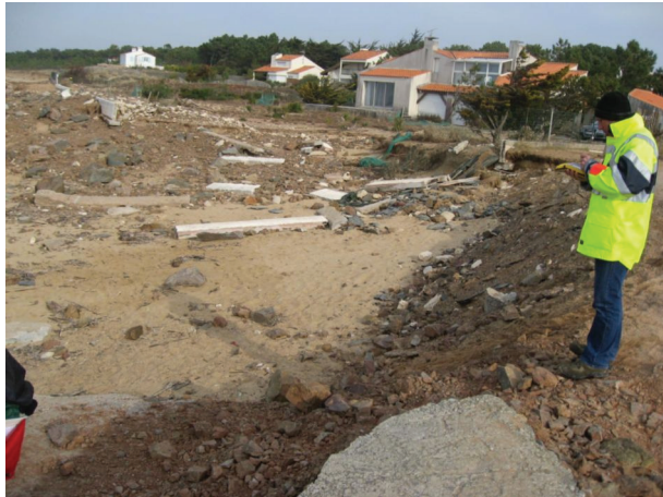
Illustration 9 : Clôtures détruites suite à la tempête Xynthia (Cerema Ouest, La Tranche-sur-Mer, 2010)
