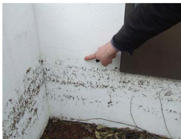
Illustration 18 : Levé de PHE (Cerema Ouest, Tempête Xynthia, La Faute-sur-Mer, 2010)
