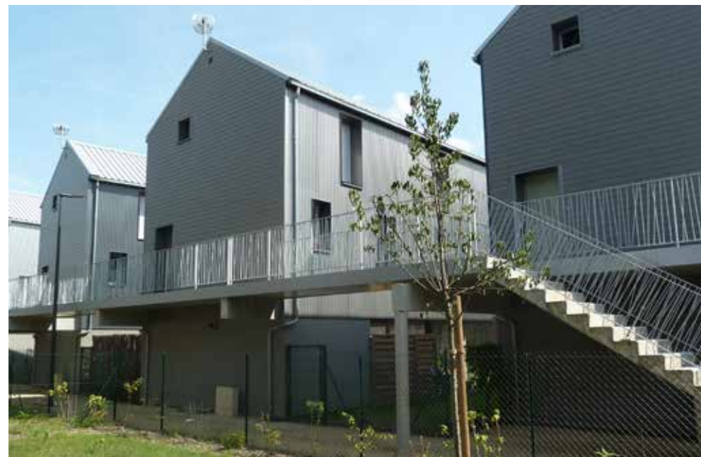
Fig.5.1 : Maisons avec passerelles surélevées dans le quartier résilient « Nouvel R' » de Saint-Pierre-des-Corps
