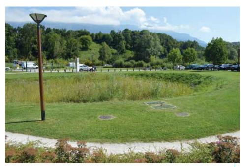
Photo 2 – Bassin de prétraitement des eaux pluviales de la RD 1201 avant reiet dans le lac du Bourget (© GRAIE)
