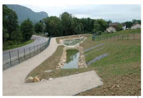
Photo 2 – Bassin de stockage des eaux de pluies, ZAC des Drouilles à Challes-les-Eaux (© Chambéry métropole)
