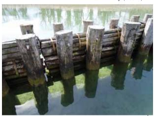
Photo 2 – Ouvrage de protection sur le lac d'Annecy de type «fascine imputrescible» «
