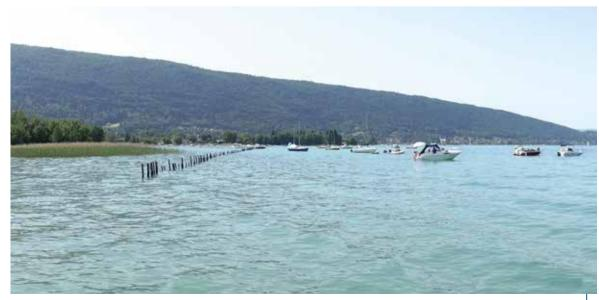
Photo 1 – Les ceintures de pieux disposées en front des roselières ont pour objectif d'empêcher l'intrusion des embarcations. Elles constituent un repère visuel et physique efficace, le plus souvent respecté par les plaisanciers (© D. Zanella – SILA)
