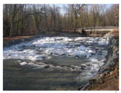
Photo 2 – Rampe en enrochements sur la Venoge, affluent du Léman (© F. Hofmann)
