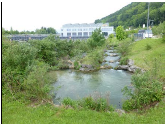
Centrale électrique de Ruppoldingen (Suisse) montrant des mesures prises pour le passage des poissons et les habitats : avec l'aimable autorisation de Jukka Jormola, SYKE
