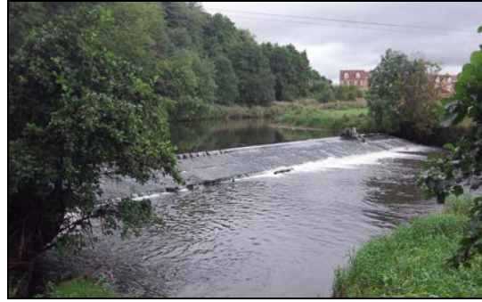
Avant le démantèlement du barrage : photo avec l'aimable autorisation de Oliver Southgate (Environment Agency, Royaume-Uni)
