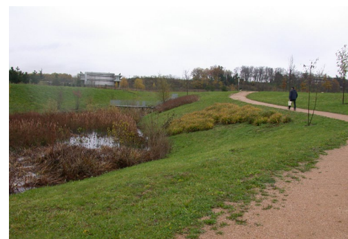
Exemple du bassin d'infiltration des eaux pluviales de Minerve sur la Métropole de Lyon
