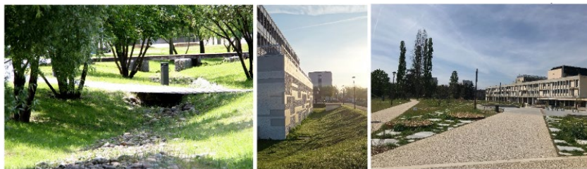
Fig. 17. | EXEMPLES DE TECHNIQUES DE GESTION DES EAUX PLUVIALES à LA SOURCE | ECOCAMPUS Lyon Tech La DOUA (Villeurbanne 69) : Tranchée, Noue, Jardin de pluie
