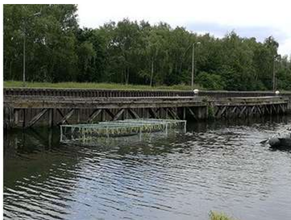
Figure 7: Radeau mis en place dans le cadre du projet. © CR Sambre
