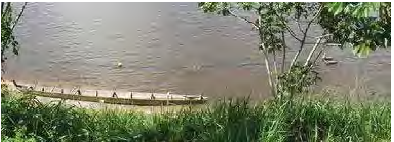
Prise d'eau par pompe flottante en rivière à New Wacapou
