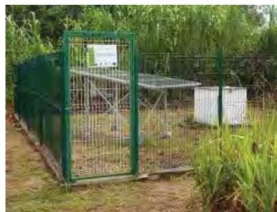
Forage à Trois Palétuviers
