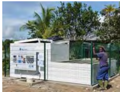
Station RFL d'Apagui munie de panneaux solaire, d'un réservoir en béton et une borne-fontaine
