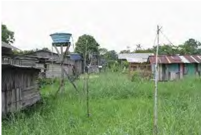
Réseau d'eau à partir d'un puits
