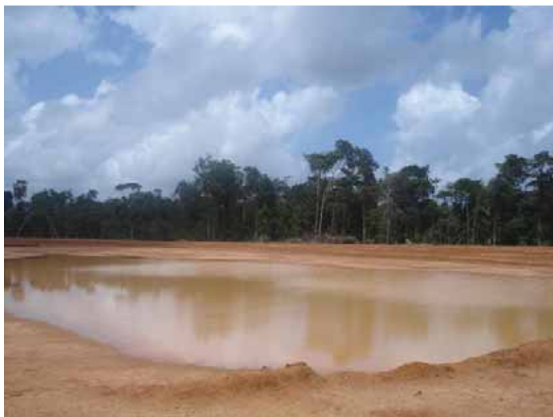
Lagune d'assainissement de Saint Georges de l'Oyapock
