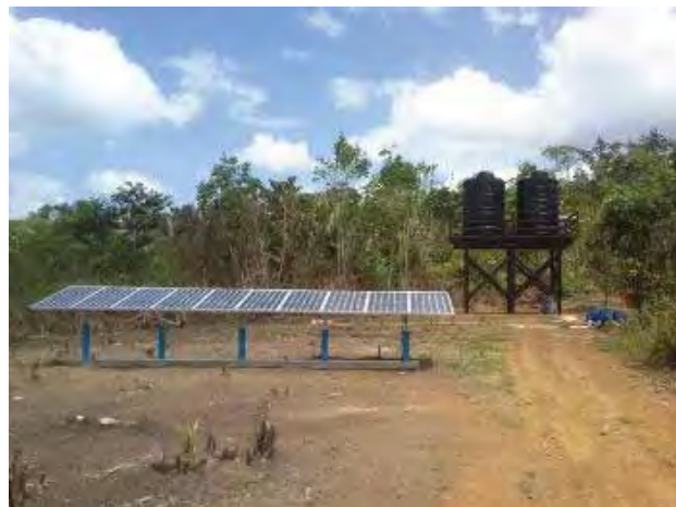
Réservoir de Saint Soit
