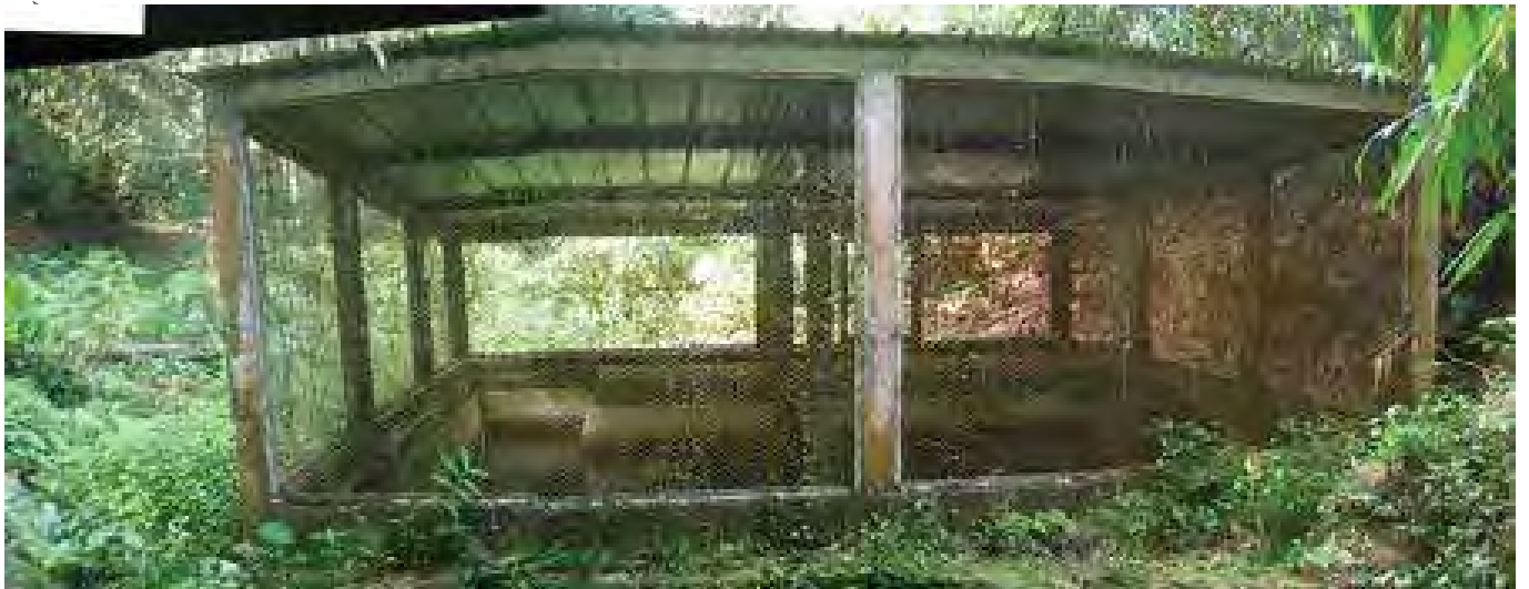
Prise d'eau captage de sources à Saül
