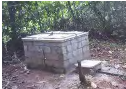
Forage à Ouanary
