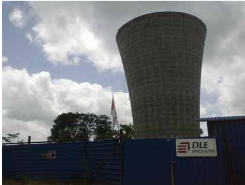
Réservoir de Grand Santi
