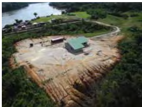
Chantier de Providence
