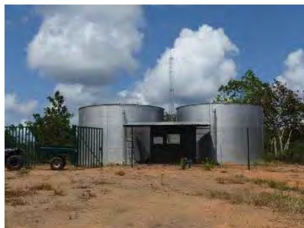
Château d'eau de Camopi
