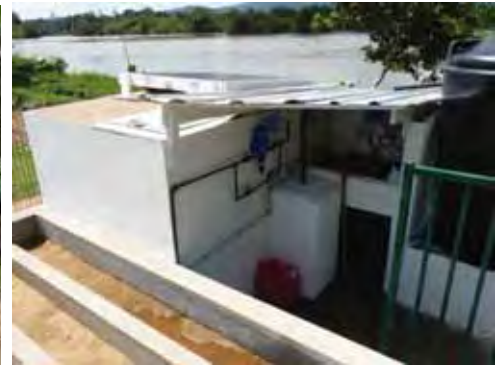
Station RFL d'Apagui munie de panneaux solaire, d'un réservoir en béton et une borne-fontaine
