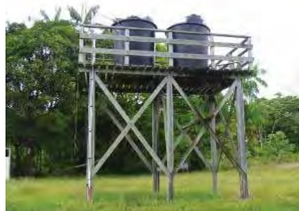
Château d'eau de Twenké
