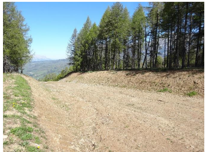
Figure 1 – Piste de Vernie Rouge avant re-végétalisation, © CBNA
