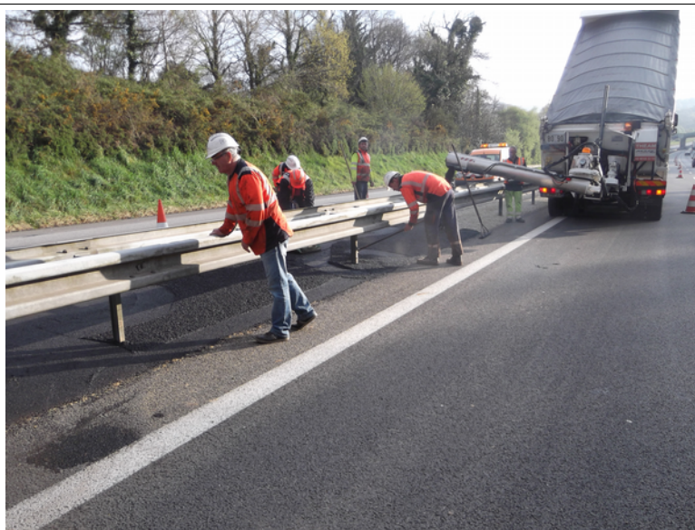
Photo n°4 : Revêtement de TPC (DIR Ouest)
