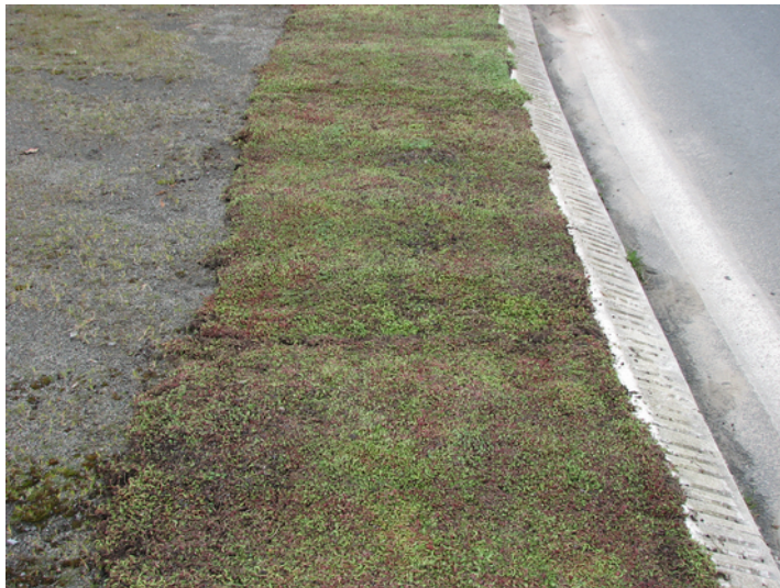
Photo n°1 : Expérimentation de sedum sur îlot directionnel (DIR Ouest / CEI Brest)
