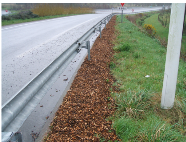
Photo n°2 : Paillage pied de glissière (DIR Ouest / CEI Loudéac)
