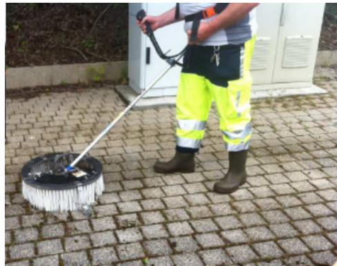
Photo n°6 : Balayage des zones pavées (ASF)
