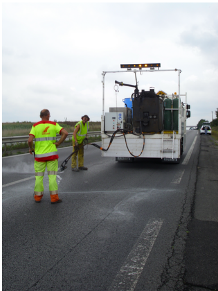
Photo n°12 : Opération de pontage (DIR Ouest)
