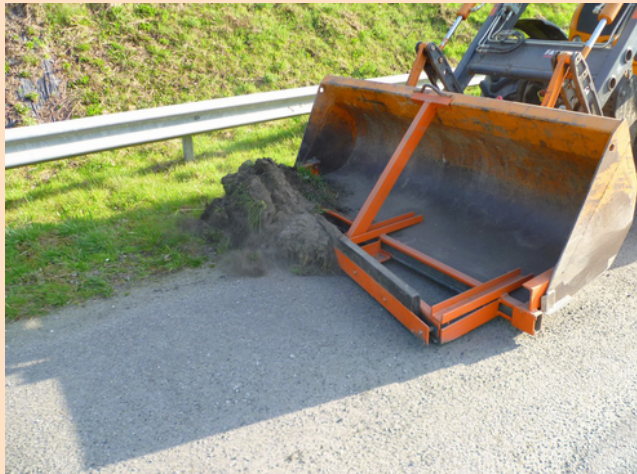
Photo n°14 : Raclage de la BDG sur TPC de 2x2 au godet adapté (Dir Ouest : CEI Loudéac)
