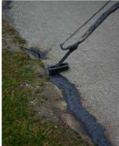
Photo n°11 : Pontage de fissure (DIR Nord)
