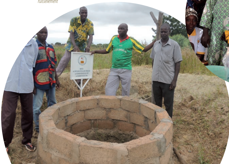
Puits avec margelle, pour empêcher le ruissellement
