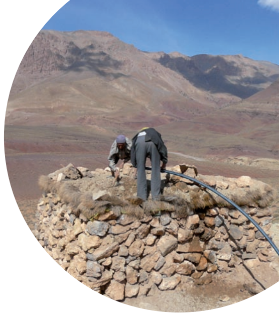
Finition du château d'eau
