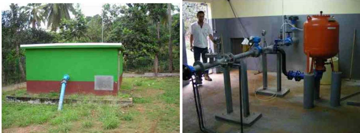
Fig. 38. Vue du local et du forage en septembre 2011
