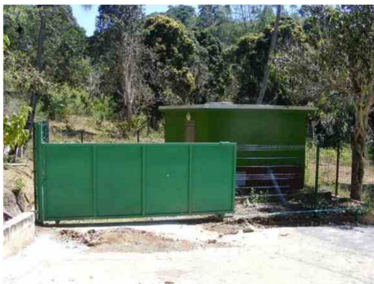
Local de pompage et clôture extérieur
