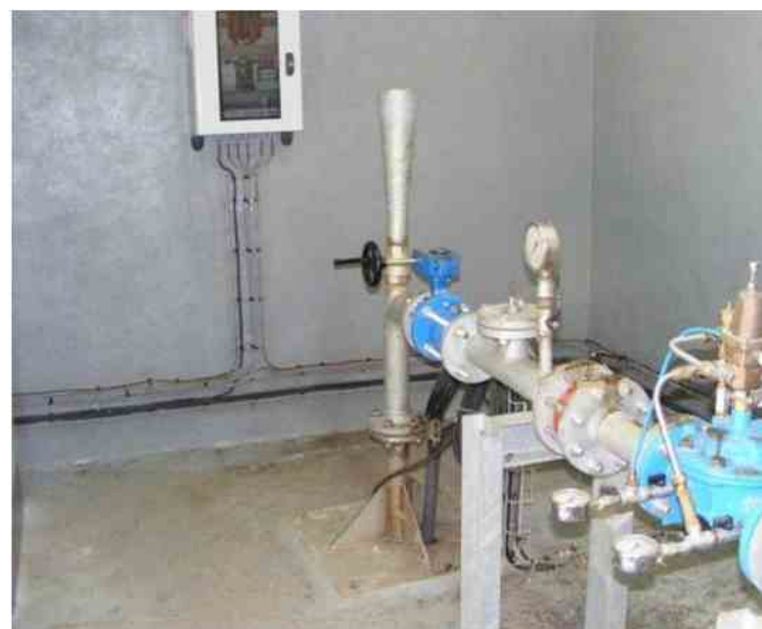
Vue du forage
