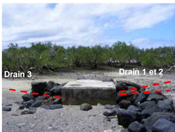
Puits de pompage
