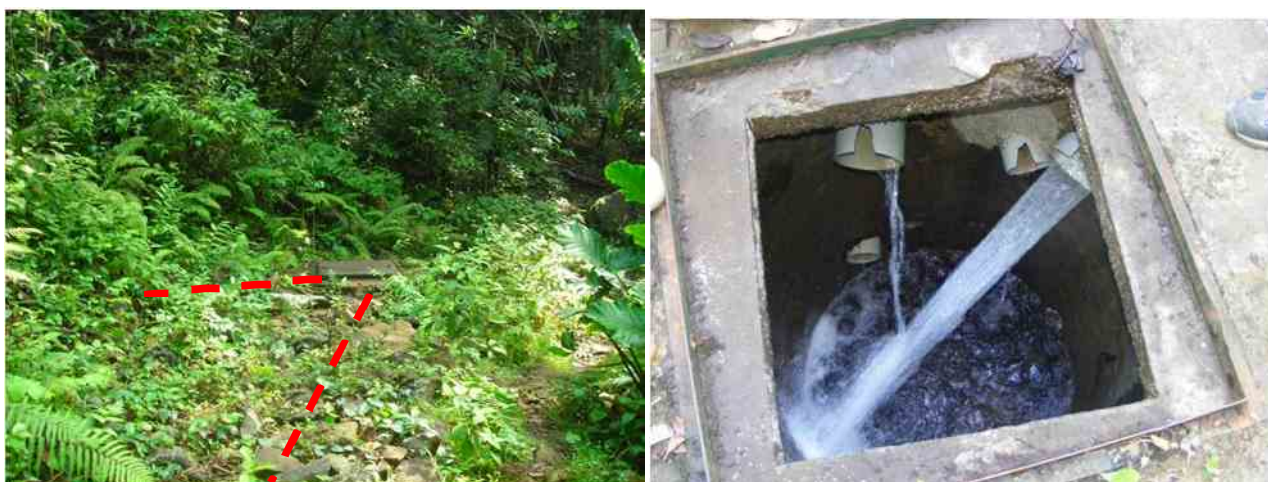
Fig. 47. Drains de M'réréni : drain n°1 amont
