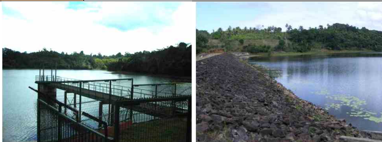
Fig. 45. Tour de prise et digue de la retenue de Combani
