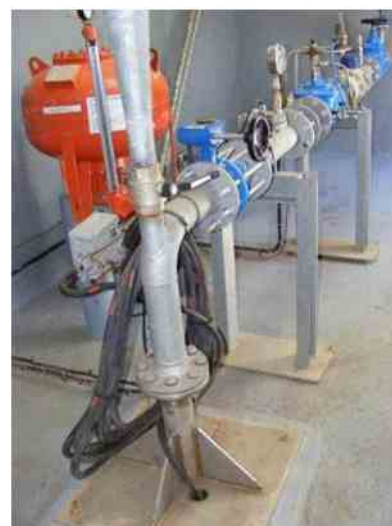
Vue du forage
