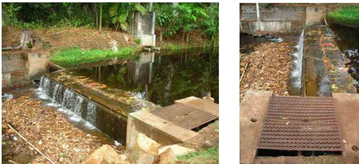
Fig. 25. Seuil et prise d'eau de Bouyouni Bas
