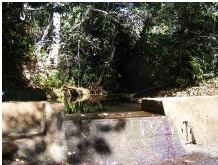
Fig. 10. Prise d'eau de Gouloué
