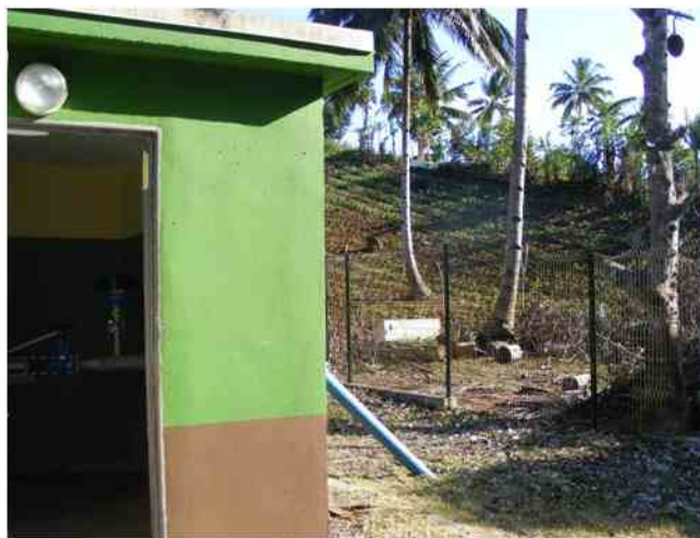
Fig. 50. Bâtiment et clôture du forage de Combani-Miréréni
