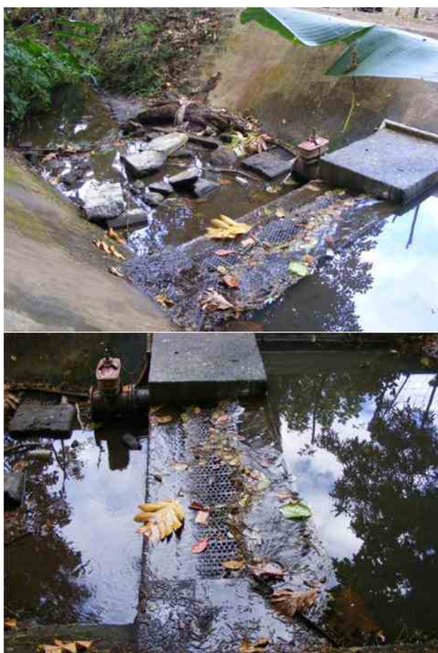
Fig. 36. Prise d'eau de Méresse (septembre 2011)
