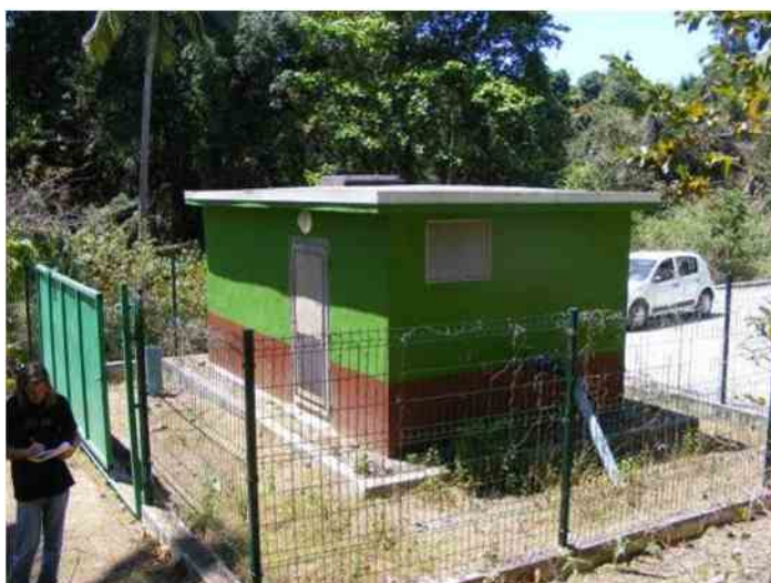
Local de pompage et clôture extérieur
