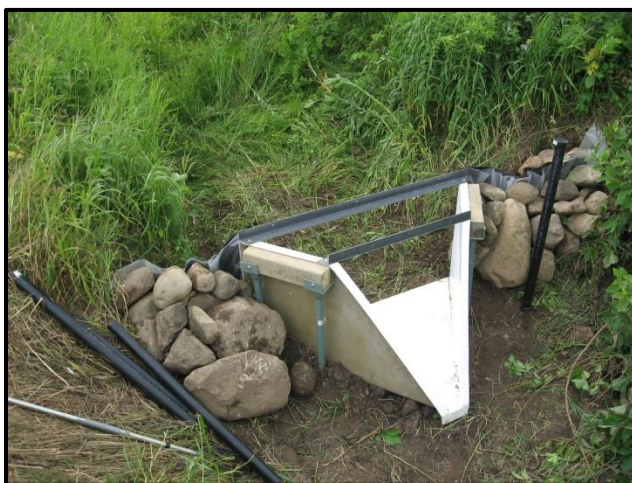
Figure A.2 - Installation du déversoir sur le site Girard en juin 2010 (Photo : Mikael Guillou).
