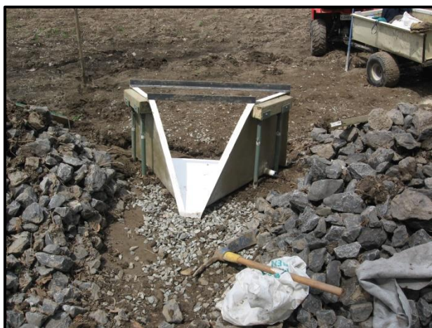
Figure A.1 - Installation du déversoir sur le site Berna au printemps 2010 (Photo : Mikael Guillou).
