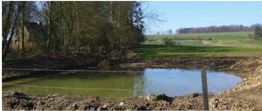
Mare tampon à double niveau, installée à Libois, juste après l'aménagement.
