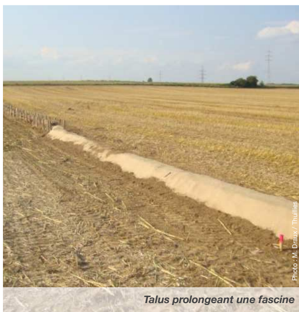
Talus protégé par géotextile, enherbé
