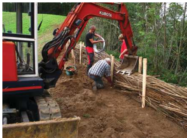
Remplissage en « tuiles », en veillant à ne surtout pas laisser d'espace vide entre les fagots.
