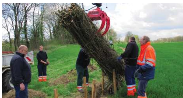
Mise en place des fagots, à la main ou à la grue selon la taille. Attention à la qualité des fagots: branches fines!
