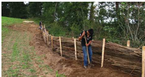
Rebouchage manuel des derniers espaces entre les fagots et le sol, puis inspection soigneuse de l'ensemble.
