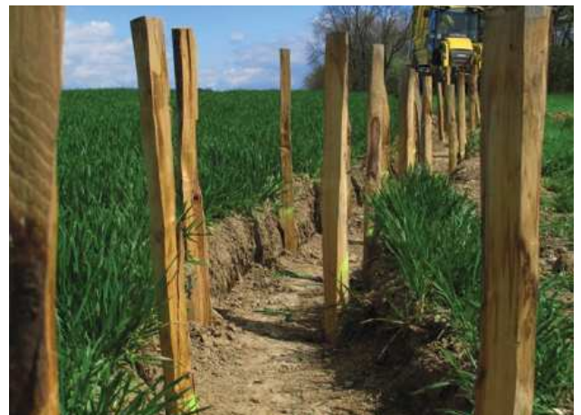
Creusement de la fosse, avec un godet adapté à la largeur des fagots
