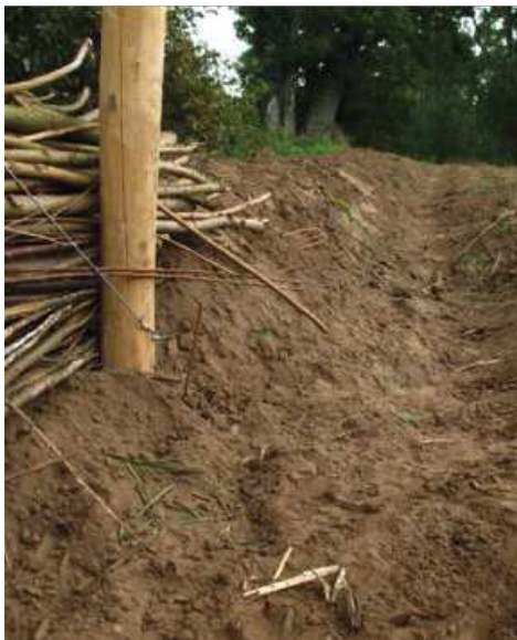
Finition des bords de la fascine par un ados de terre. Semis d'herbe sur les zones de terre nue.
