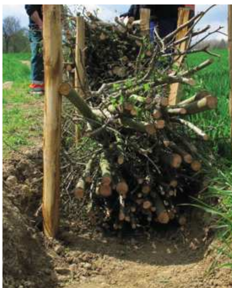
Mise en place des fagots, à la main ou à la grue selon la taille. Attention à la qualité des fagots: branches fines!
