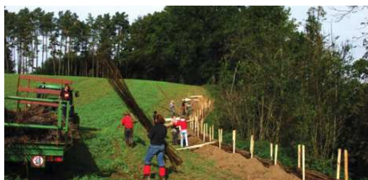
Mise en place des fagots, à la main ou à la grue selon la taille. Attention à la qualité des fagots: branches fines!
