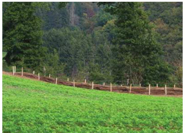
Finition des bords de la fascine par un ados de terre. Semis d'herbe sur les zones de terre nue.
