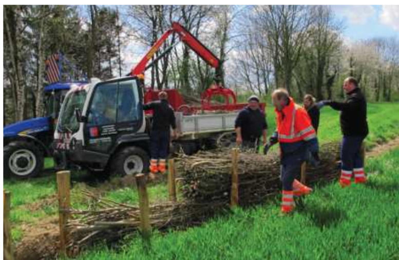
Remplissage en « tuiles », en veillant à ne surtout pas laisser d'espace vide entre les fagots.
