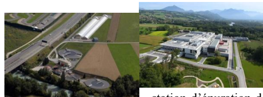
station d'épuration de
