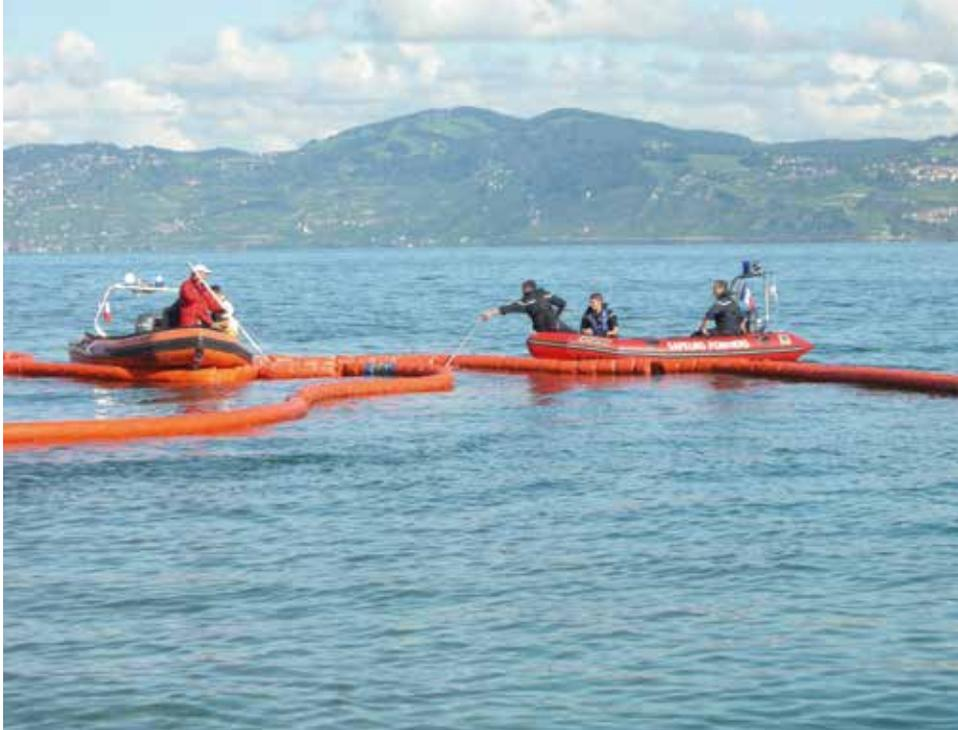
Photo 2 – Pose de barrages flottants sur le Léman (© CIPEL)
