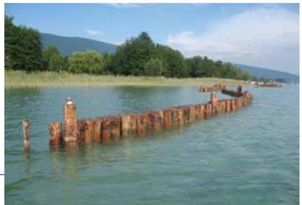
Photo 3 – Ouvrage de protection sur le lac d'Annecy construit à l'aide de pieux jointifs (© D. Zanella – SILA)
