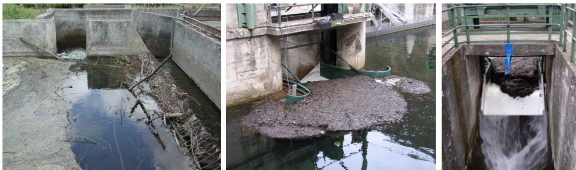
Figure 59 : Encombrement de dispositifs de dévalaison
