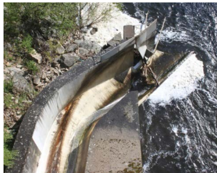
Figure 61 : Glissière de dévalaison endommagée
