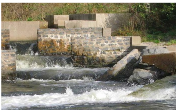
Figure 47 : Prébarrage dont un muret est écroulé
