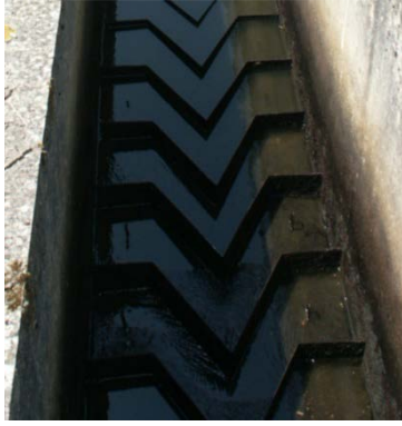
Figure 31 : Ralentisseurs de fond suractifs
