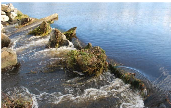
Figure 51 : Rampe en enrochement encombrée
