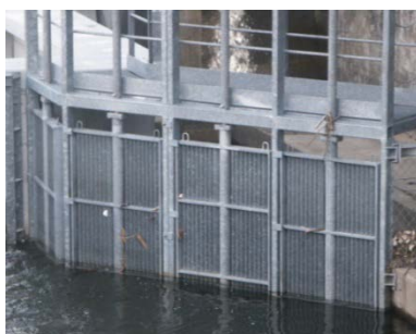
Figure 15 : Grilles d'injection de débit d'attrait pivotantes autonettoyantes
