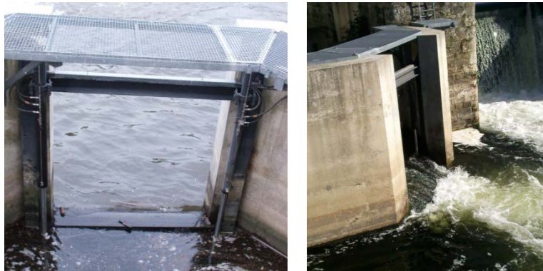
Figure 27 : Vanne de régulation de la chute au niveau de l'entrée piscicole d'une passe à bassins
