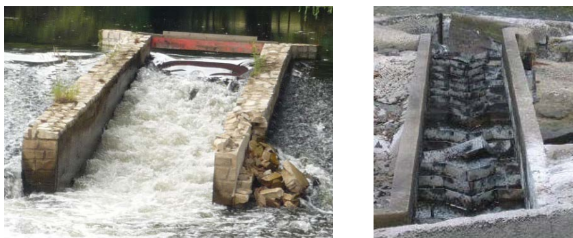
Figure 9 : Passes à ralentisseurs ayant subi une dégradation d'un muret (à gauche) et de ralentisseurs (à droite)
