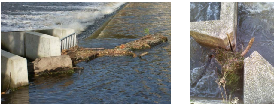
Figure 7 : Encombrement d'une entrée hydraulique (à gauche) et d'une échancrure interbassins (à droite)
