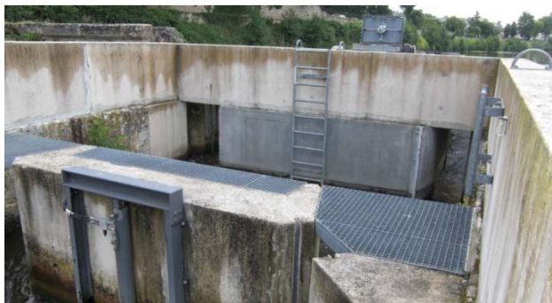
Figure 12 : Echelles d'accès et passerelles en caillebotis
