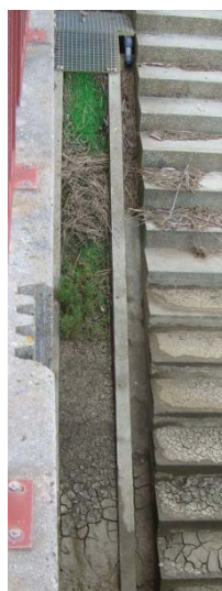
Figure 45 : Passe à anguilles en "tapis brosse" colmatée par des sédiments
