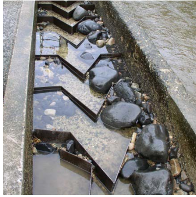
Figure 37 : Passe à ralentisseurs de fond engravée
