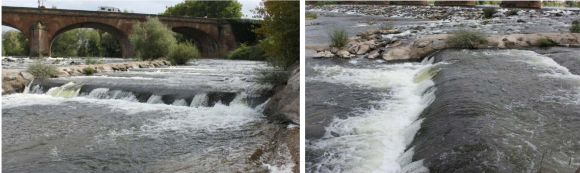
Figure 10 : Augmentation de la hauteur de la chute aval d'une rampe en enrochement liée à l'incision du cours d'eau
