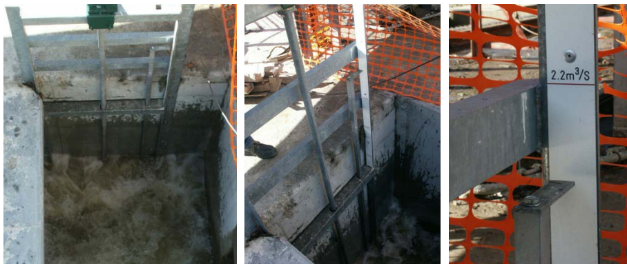
Figure 26 : Vanne de régulation du débit d'attrait complémentaire
