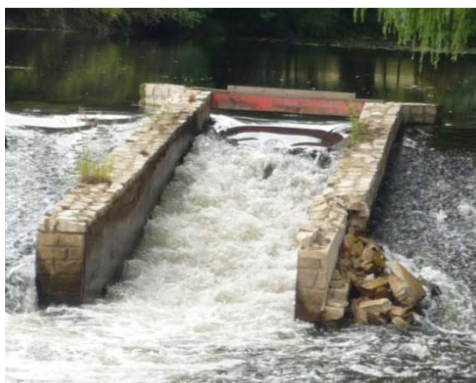
Figure 35 : Muret d'une passe à ralentisseurs partiellement écroulé
