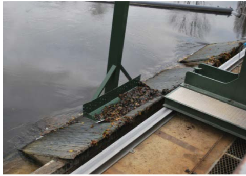
Figure 60 : Dégrillage en cours de réalisation
