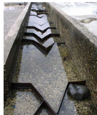
Figure 36 : Passe avec des ralentisseurs dégradés
