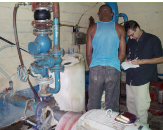
Diagnóstico de una planta de desinfección con cloro en cooperación con REGIDESO
