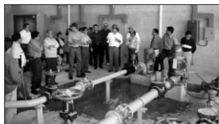
La plataforma piloto para bombeo y canalizaciones
