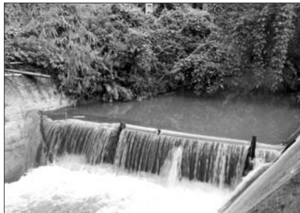
El Río Ouroveni en el punto de toma para la alimentación de la planta
