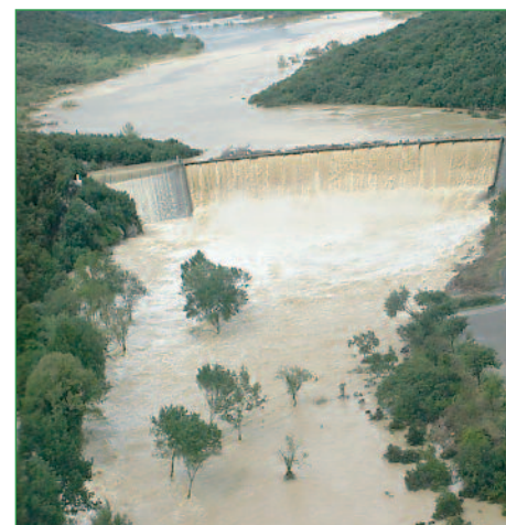
Inundación de la presa de la Rouvière en 2002
